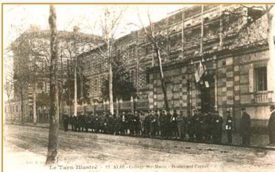
Les militaires blessés en 1917. Remarquez les échafaudages devant l'aile en construction !
